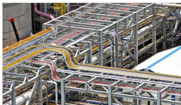
для монтажа кабельных трасс
