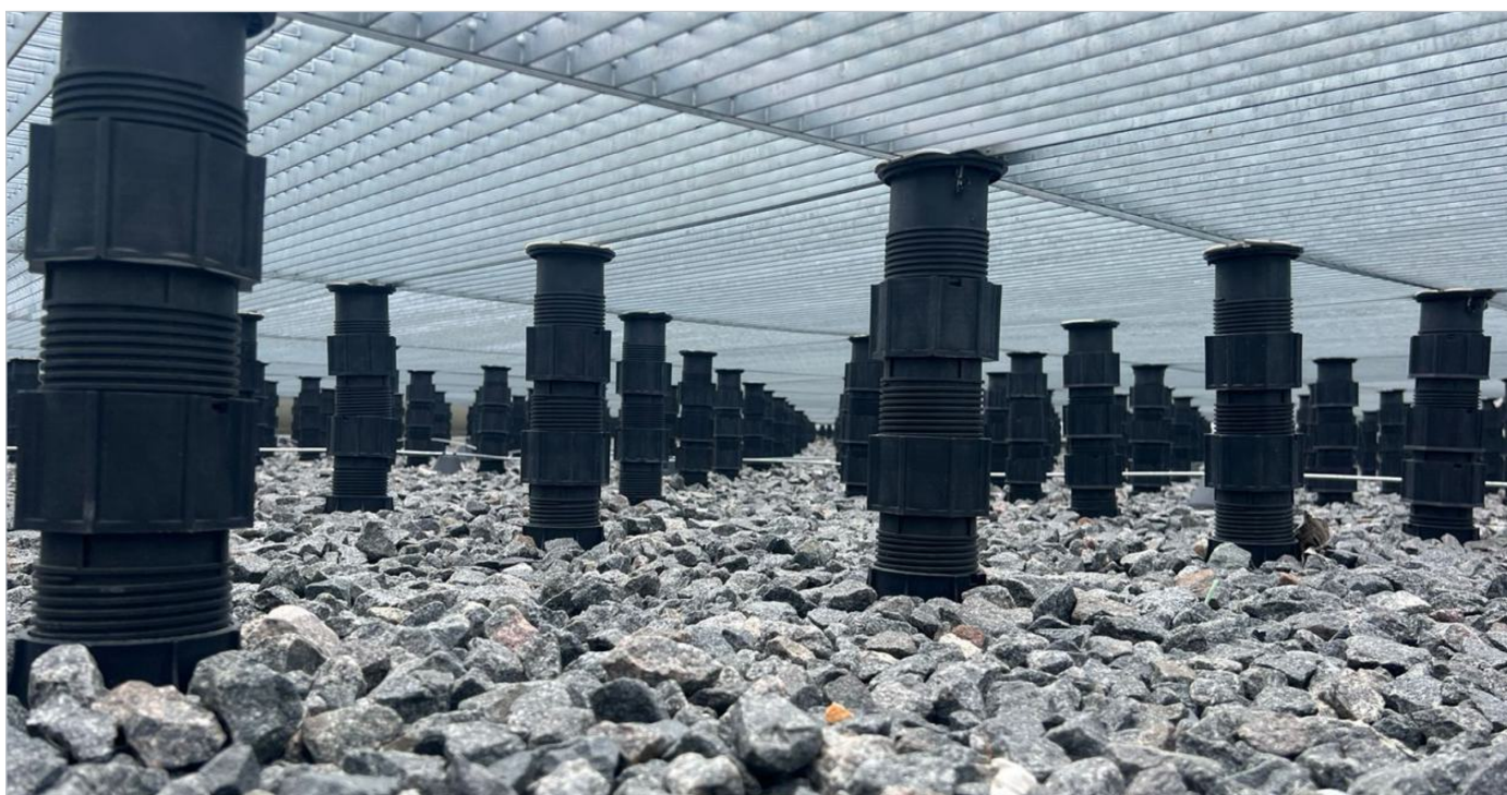
ОБЪЕКТ: Филиал Третьяковской галереи. Калининград. Регулируемые опоры HILST LIFT и Решетчатый настил HILST.
