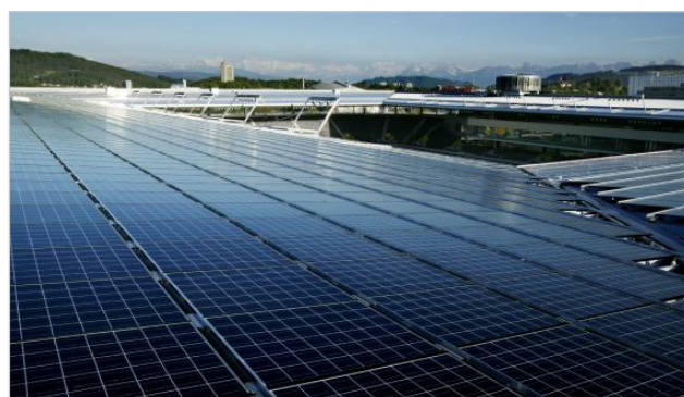
для монтажа солнечных батарей
