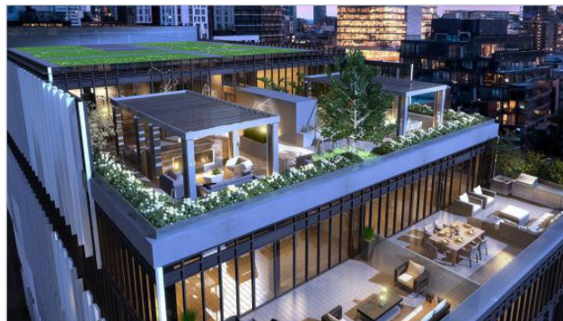
эксплуатируемые кровли торговых и бизнес-центров
