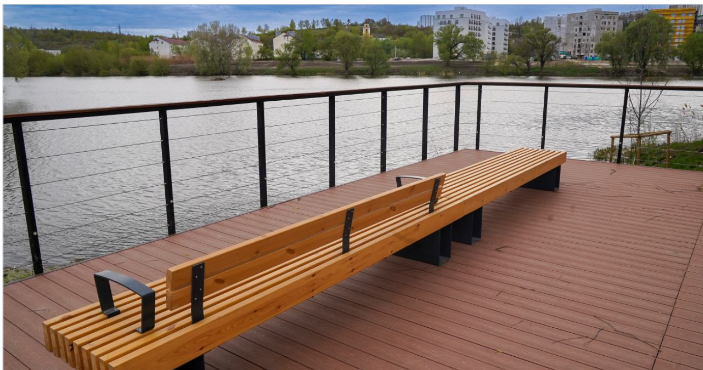
ОБЪЕКТ: Парки. Москва. Четыре парковых комплекса с использованием террасной доски HILST DECK и перил для ограждений HILST.
